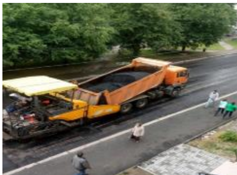
Рисунок6.Регенерация дорожной одежды
